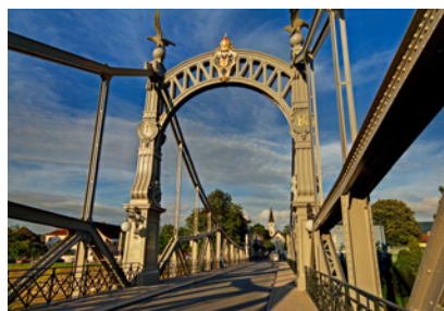
Ponte di confine tra Laufen ed Oberndorf
